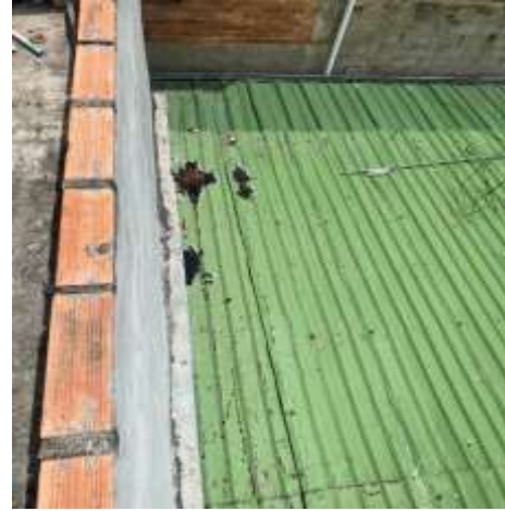
Estado de techo Almacén
